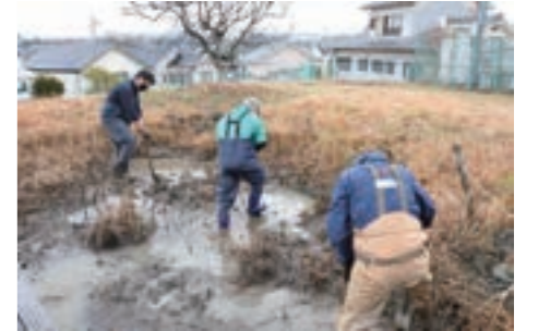
池の泥上げ作業の実施
