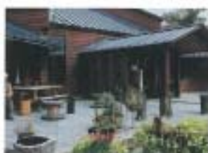
ネイチャーセンターは、鉄骨造1階建て。外観は、木で自然環境とよくマッチしています。
